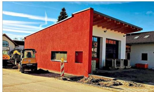
Der aktuelle Stand der Dinge: So sieht es im Dezember bei der Erweiterung des Feuerwehrgerätehauses derzeit in Seibersdorf aus. – Fotos: Gemeinde
