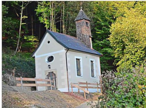
Runderneuert innen wie außen und wieder gut zugänglich ist die Stadlecker Kapelle. – Fotos: Schmid
