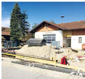
Feuerwehr und Gemeindeverwaltung hoffen auf einen unfallfreien und reibungslosen Bauverlauf und werden im Mitteilungsblatt regelmäßig über den Fortgang der Baustelle berichten.
