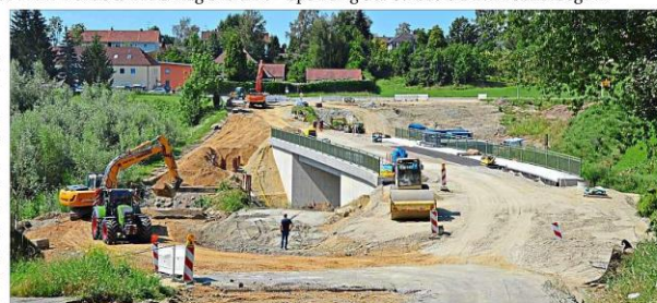
Die Brückenbaustelle im Überblick. Links entfernt der Bagger gerade den Damm der früheren THW-Behelfsbrücke. Die neue Brücke rechts muss nun noch an die Straße angebunden werden. Bis zum Ende der Ferien soll alles fertig sein. – Foto: Kaiser
