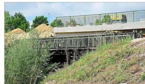
Die Behelfsbrücke des THW (im Vordergrund) erfüllte vier Jahre lang ihre Dienste. Dahinter entsteht die neue Schulstraßenbrücke.
