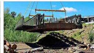
In einem Stück wurde die Konstruktion vom Autokran entfernt. Das THW wird sie in den nächsten Wochen zerlegen. – Fotos: Hartwig
