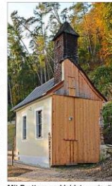
Mit Brettern verkleidet wurde die rückwärtige Sella, wo das abgerissene Wohnhaus angebaut war.
