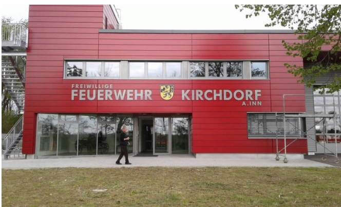
25.04.2017 Schriftzug wird an der Fassade angebracht
