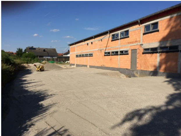
07.07.2016 Der Außenbereich wird angelegt
