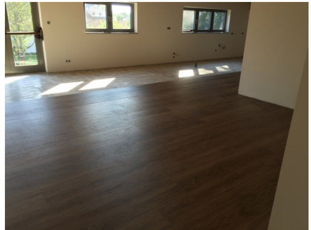
18.07.2016 Die Böden im OG Sozialtrakt werden gelegt
