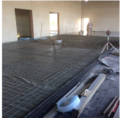
11.04.2016, Rüttelfliesen werden in die Halle eingebracht.
