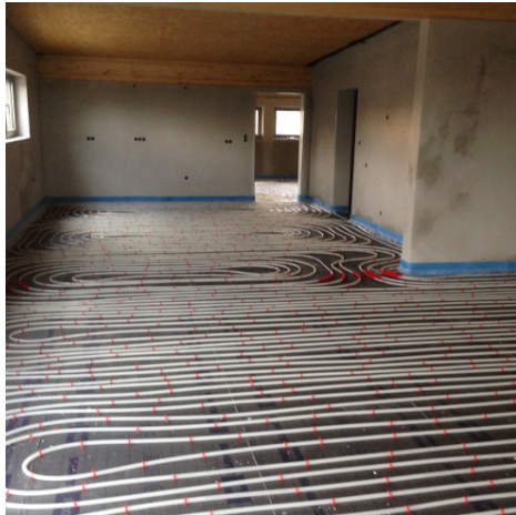
31.03.2016 Fußbodenheizung wird verlegt
